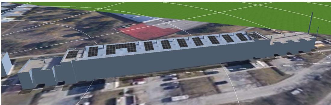
Bild 2: Anordnung PV-Module - Stiege 1
